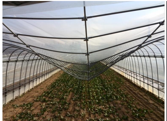
古里でほうれん草を栽培している方のハウス 雪の重みでパイプが大きく変形
